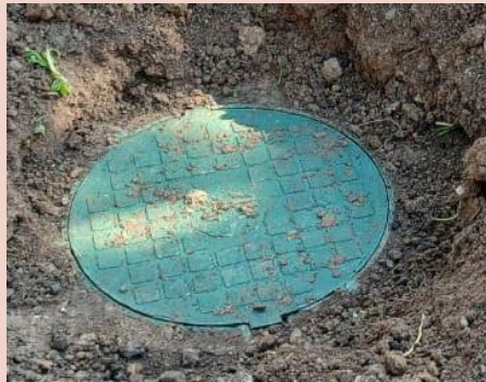
Устройство наружных сетей водоотведения многоквартирного дома №13 по ул. Заводской в г. Грязовец
