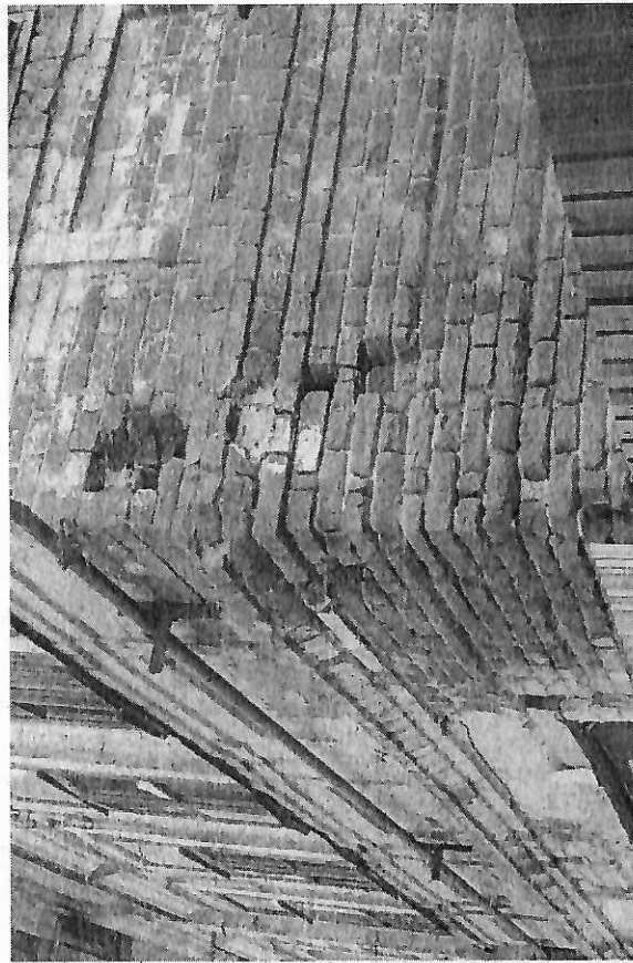
Фото 14. Сквозные диагональные трещины над окнами.
