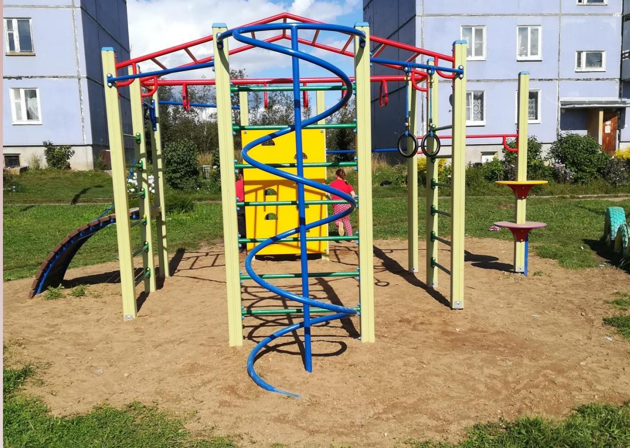
Устройство детской площадки д.Спасское
